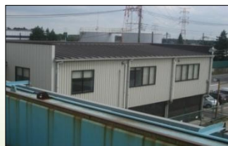
写真2 - 未塗装の建屋
